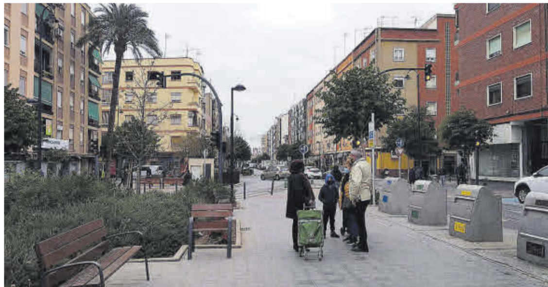
En esta obra se han ampliado las aceras y se han aumentado las zonas verdes.
